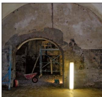
Nei vecchi fabbricati spesso i locali interrati sono interessati da umidità e infiltrazioni d'acqua. Risolvere il problema dall'interno senza scavare in esterno diventa importantissimo.
