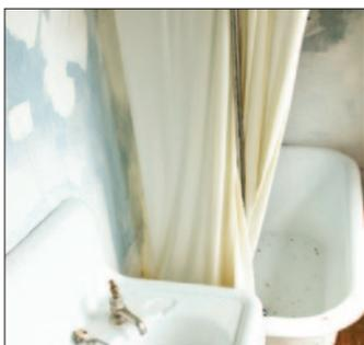
Nei vecchi locali di servizio: bagni, cucine, ripostigli la mancanza di adeguata coibentazione provoca la condensa del vapore acqueo con considerevole deterioramento della pittura e formazione di muffe.
