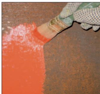
**GRILLO:** smalto alchidico a solvente, da applicare in due mani distanziate di 24 ore con una resa di 10-12 m<sup>2</sup>/l per mano corrispondenti a 40-50 micron secchi.
