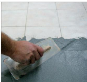
Il vecchio terrazzo presenta qualche piccola infiltrazione ma il pavimento è ben solido e c'è uno spazio sufficiente per poter sovrapporre una nuova pavimentazione in piastrelle.
