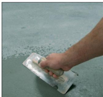
Il vecchio pavimento in piastrelle è stato rimosso e si vuole creare uno strato impermeabilizzante prima della posa delle piastrelle.
