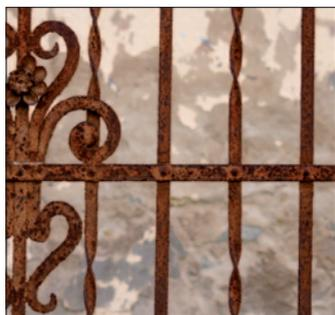
Il ferro esposto all'aria, se non protetto, si ossida rapidamente con conseguente graduale perdita dell'integrità strutturale del manufatto. I fenomeni ossidativi inoltre, anche dal loro primo insorgere, generano inestetismi con macchie, colature, sbollature. E' pertanto importante provvedere ad una adeguata protezione del supporto nuovo od al suo ripristino se i prodotti di protezione applicati mostrano segni di degrado.
