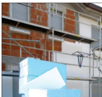
partendo dal basso verso l'alto, battuti con frattone di legno, controllando ad intervalli regolari la planarità di quanto posato. Contemporaneamente alla posa delle lastre, procedere ad un fissaggio meccanico, impiegando i tasselli previsti, in ragione di 6-8/m<sup>2</sup>.
