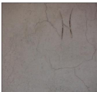
Nelle costruzioni edificate negli anni '60/'70 spesso nasce il problema di recuperare l'intonaco ancora in buono stato, ben ancorato al supporto, resistente, ma con presenza di microcavillature sparse e/o eventuali piccole sbrecciature.
