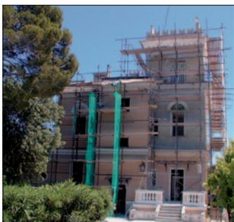
Nel restauro e nella ristrutturazione dei vecchi fabbricati è basilare impiegare prodotti che abbiano coefficienti di resistenza, di adesione al supporto, di permeabilità al vapore e di assorbimento all'acqua simili ai vecchi materiali da costruzione.
