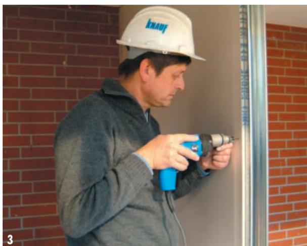
Nei casi di pareti alte, ove le lastre non raggiungano l'altezza della parete, si dovranno sfalsare i giunti tra le lastre di almeno 400 mm. La lunghezza delle viti deve superare almeno di **1 cm** lo spessore delle lastre.
