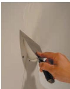
Distribuire uno strato abbondante e omogeneo di stucco lungo il bordo delle lastre fino a raggiungere il livello della superficie della lastra. Lo stucco deve essere preparato in modo da avere adeguata fluidità e scorrevolezza per stendere il nastro in carta.
