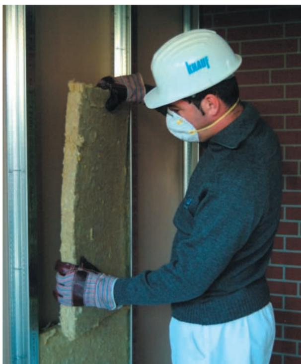
Lane di vetro a bassa densità, ad alta capacità fonoassorbente, incrementano il potere fonoisolante della parete.
