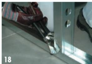
Per pareti ad alto **isolamento acustico**, si realizza il montaggio di due orditure parallele, separate da intercapedine (Sistema Knauf W115).
