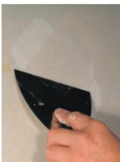
La stuccatura avviene in tre mani: una prima mano di riempimento (che nella stuccatura con la carta è preceduta da una mano leggera per attaccare il nastro) e due mani successive di finitura e liscivatura del giunto.
