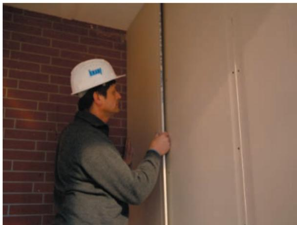
Nel caso di pareti a triplo strato di rivestimento (tre lastre per lato, sistema **W113**), ogni strato deve avere i giunti sfalsati rispetto al precedente.
